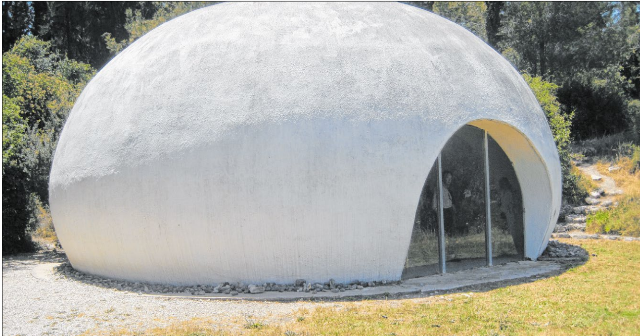
▲ In einer Talsenke am Rande des Dorfs hat sich Bruno Hussars Traum von der „Doumia“, einem „Haus des Schweigens“, verwirklicht. Das ungewöhnliche Gebäude ist ein Ort zum Nachdenken, Meditieren und Beten. Fotos: Fleckenstein (2)
