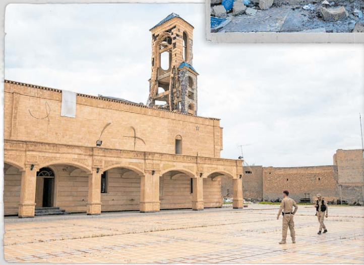
▲ Die Marienkirche in Karakosch wurde ebenfalls schwer beschädigt.
