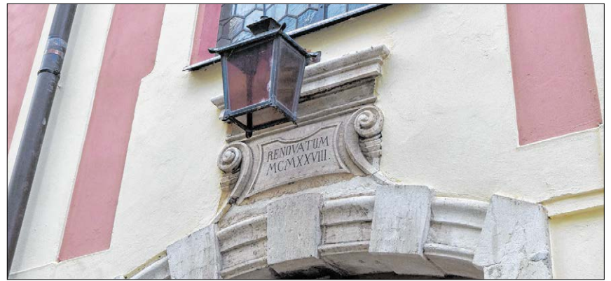
▲ Über dem Eingangsportal erinnert eine Inschrift an eine Restaurierung im Jahr 1928: „Renovatum MCMXXVIII“.
