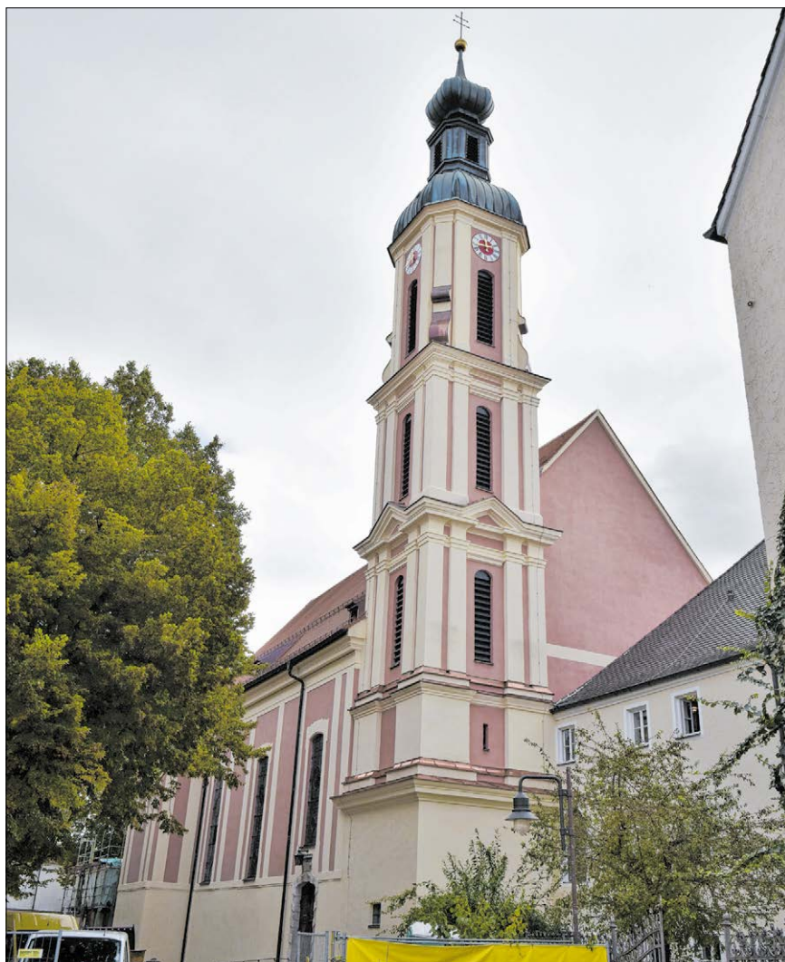
▲ Die Pfarrkirche Heilig Geist in der Unteren Stadt von Neuburg an der Donau wurde für 2,4 Millionen Euro saniert.
