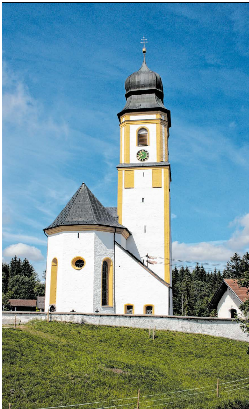
▲ Die schon in der Spätgotik errichtete Kirche St. Peter und Paul in Petersthal wurde in der Barockzeit erweitert und umgebaut.
