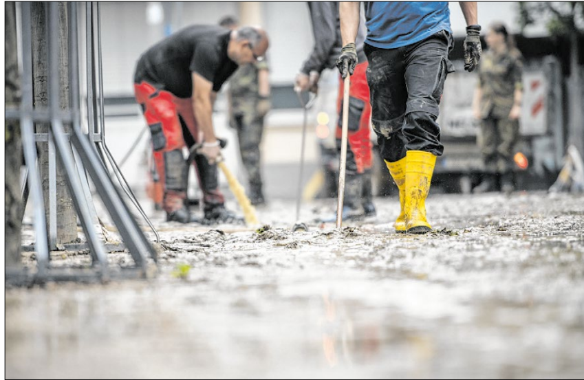
▲ Helfer befreien eine Straße in Bad Neuenahr vom Schlamm. Nach dem Aufräumen brauchen die Flutopfer dringend finanzielle Hilfe für den Wiederaufbau. Fotos: KNA
