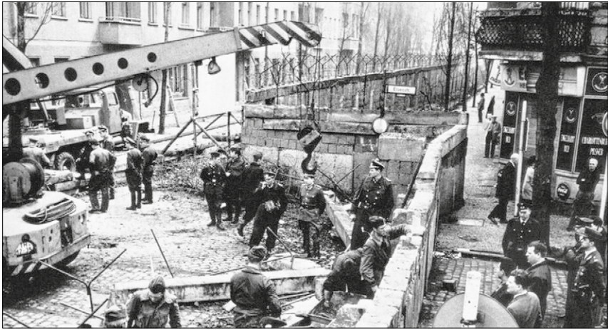
▲ Vor den Augen der geschockten Bevölkerung errichteten Volks- und Grenzpolizisten der DDR an den Sektorengrenzen die Berliner Mauer.
