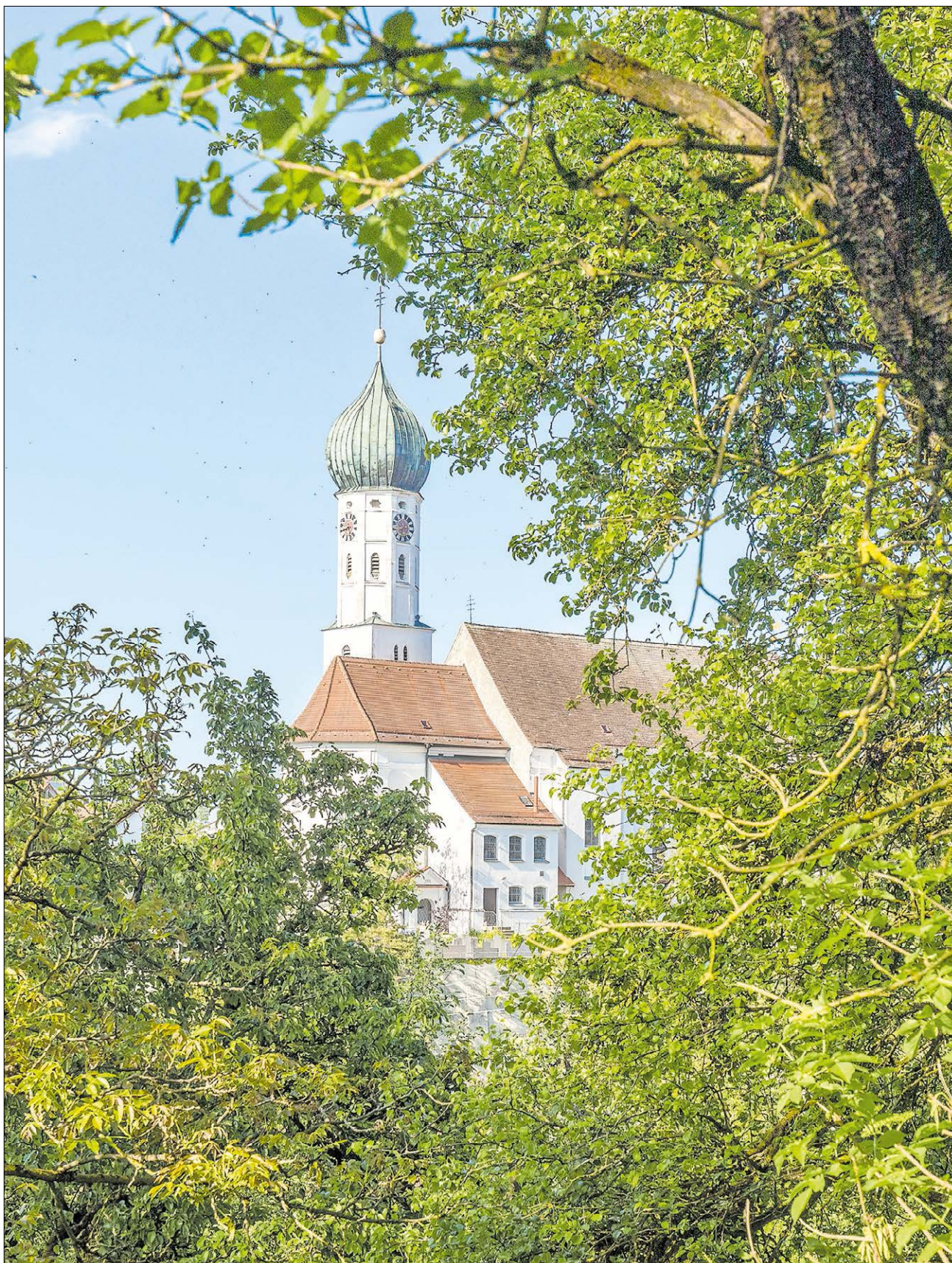
▲ Blick auf die Pfarrkirche St. Vitus und Katharina in Rehling, die 1792/93 durch Johann Singer neu erbaut wurde. Der quadratische Turmunterbau stammt vermutlich aus dem 15. Jahrhundert und wurde 1701 um das Oktogon mit der Zwiebelhaube erhöht.
