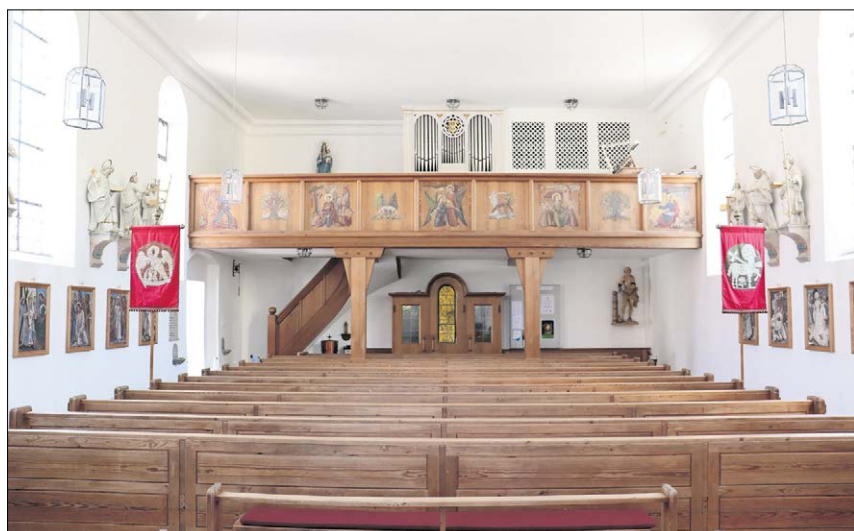
▲ Die Orgelempore und der Ausgang wurden gesichert, die Orgel saniert und der Orgelkasten neu gestrichen. Die Heiligenfiguren sind neu gefasst und teilweise vergoldet. Sogar die Sitzbänke wurden gereinigt, geölt und bekamen neue Polster.
