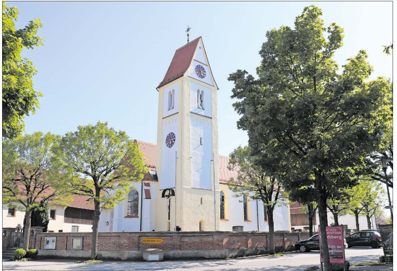
▲ Die Pfarrkirche St. Margareta In Türkheim-Irsingen hat in ihrer Geschichte schon viele Umbauten und Renovierungen erlebt. Nun war wieder eine gründliche Sanierung außen und innen dringend notwendig geworden. Das Ergebnis: St. Margareta in der Dorfmitte von Irsingen ist wieder ein Schmuckstück. Fotos: Friebe (4)
