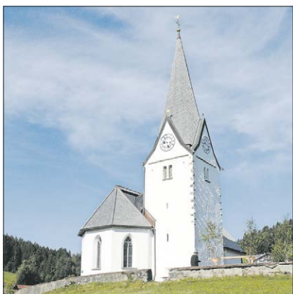
▲ Das Genhofer Gotteshaus steht an der alten Salzstraße.
