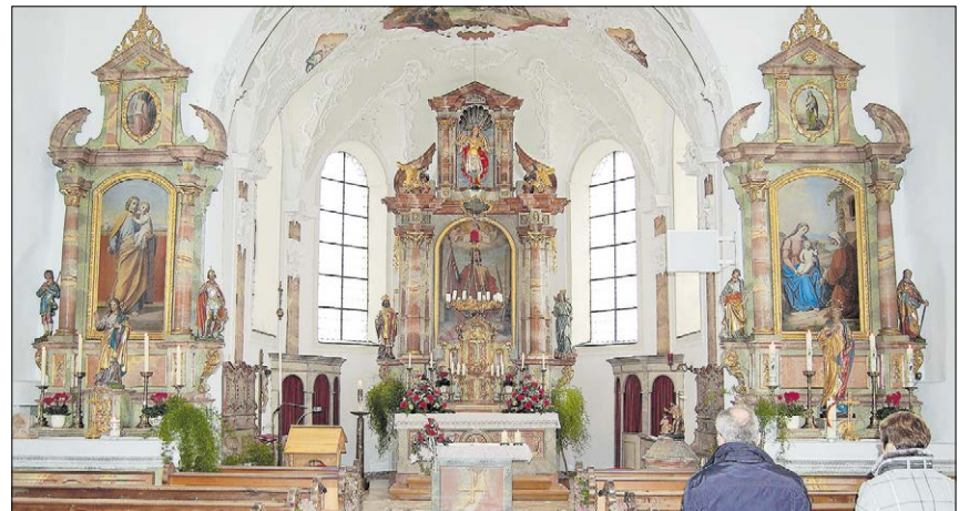
▲ Der Innenraum von St. Mauritius wurde abgewaschen und neu geweißelt, die Stuckaturen wurden gereinigt, repariert und die Decken neu befestigt. Fotos: Kleiber
