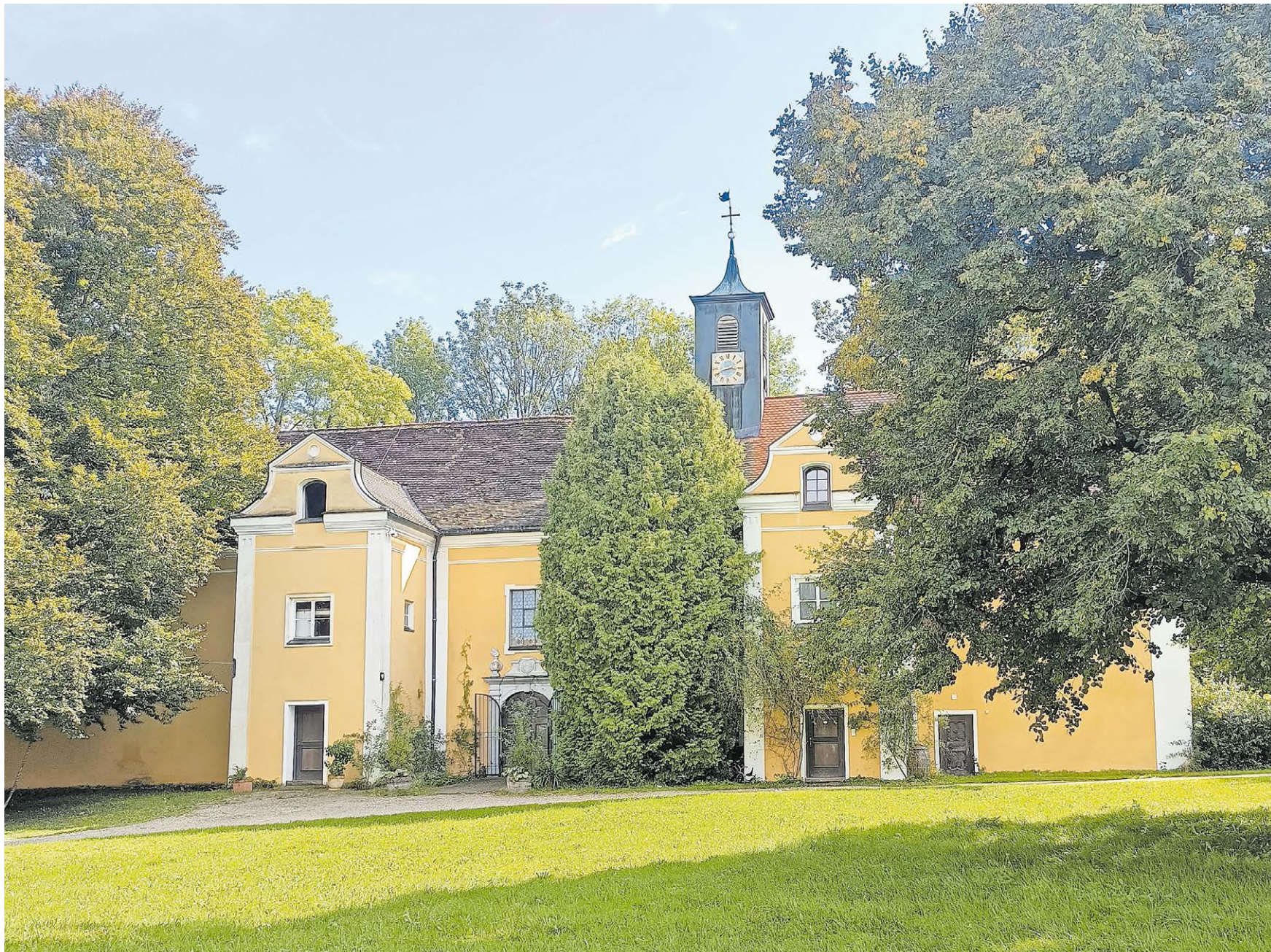
▲ Die barocke Schlosskapelle St. Maria ist Teil der ehemaligen Klosteranlage Blumenthal des Deutschen Ordens zwischen Sielenbach und Klingen. Die Ursprünge des Klosters gehen auf das 13. Jahrhundert zurück. Das einst vierflügelige Wasserschloss mit seinem umfangreichen Wirtschaftshof wurde zwischen 1568 und 1622 erbaut. Die Kapelle wurde um 1720 erweitert und barockisiert. Heute werden in ihr vor allem Hochzeiten gefeiert. 2006 wurde Schloss Blumenthal, das zuvor als Pflegeheim von Schwestern des Deutschen Ordens betreut wurde, von mehreren Familien übernommen, um ein ökologisches und gemeinschaftliches Wohn- und Lebensprojekt zu etablieren. So gibt es hier mittlerweile unter anderem einen Biergarten, ein Hotel, eine Brauerei sowie mehrere Büro- und Seminarräume. Foto: Beck
