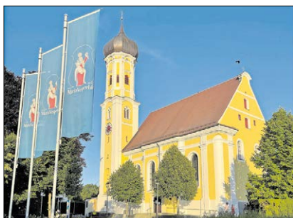
▲ In der Kirche in Maria Vesperbild sind wichtige Renovierungsarbeiten noch nicht fertig. Foto: Wallfahrtsdirektion
