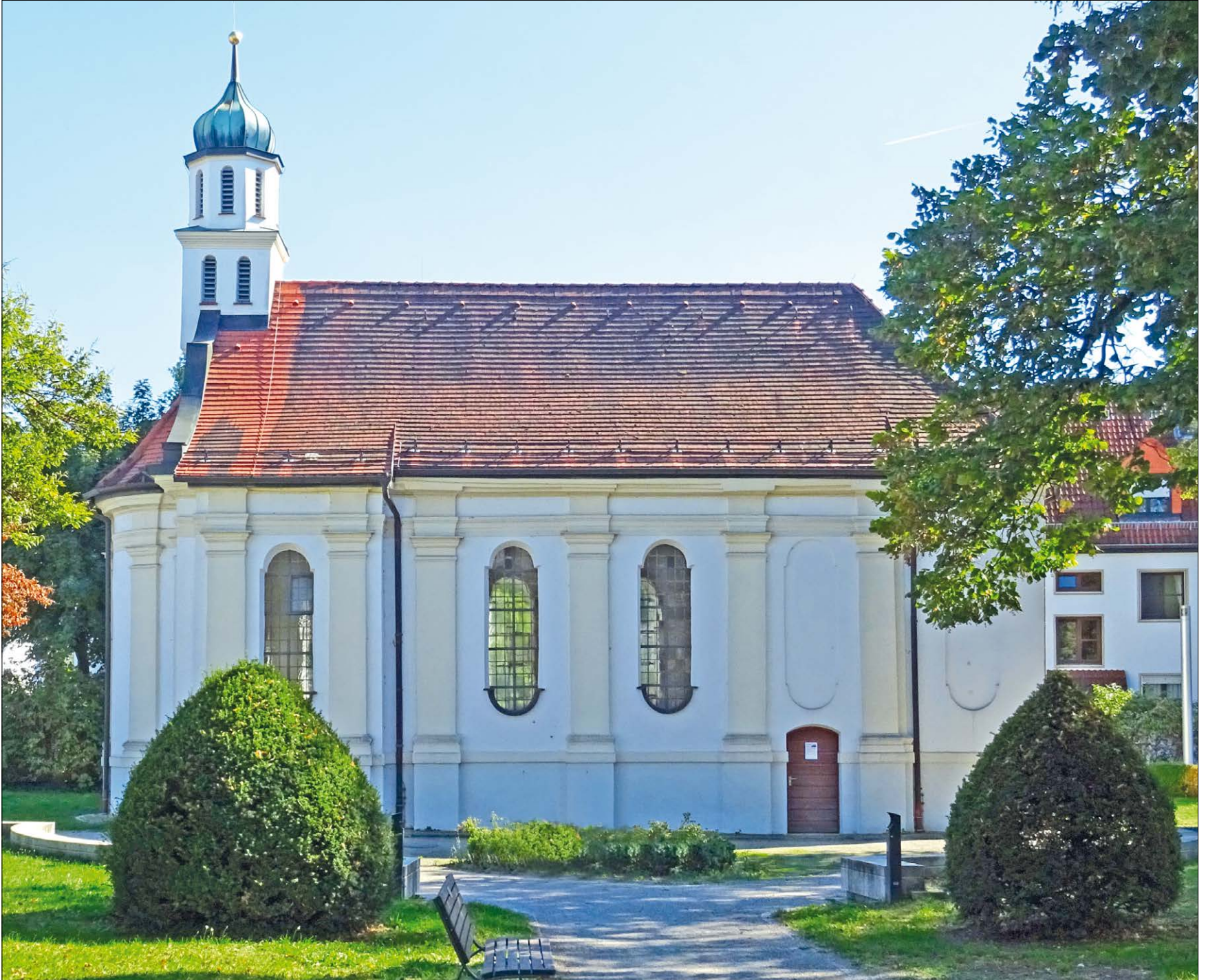
▲ Aufgrund einer Erwähnung von 1604 lässt sich die alte Kapelle St. Emmeram in Gersthofen auf das 16. Jahrhundert datieren. Nach einem zerstörerischen Hochwasser wurde sie 1671 neu erbaut und 1714 wiederum stark beschädigt. Darauf entschloss man sich die Kapelle an ihren heutigen Standort zu verlegen. Der Neubau entstand bis etwa 1722 vermutlich nach Plänen des Augsburger Baumeisters Johann Paulus. Die Weihe erfolgte 1730 durch Weihbischof Johann Jakob von Mayr. Foto: Krünes
