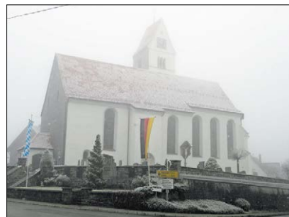
▲ Die Kirche St. Ulrich in Ebersbach.
