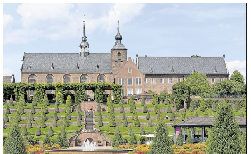
▲ Blick auf den Terrassengarten und die Abteikirche von Kloster Kamp.
