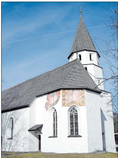
▲ Die 1515 erbaute Hüttkapelle St. Ulrich in Pflach.
