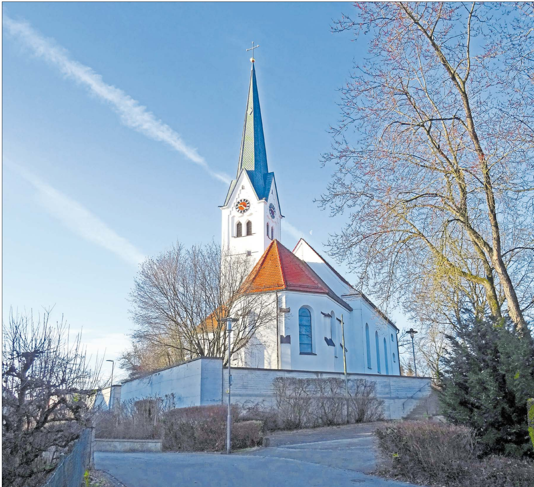
▲ Auf einer leichten Anhöhe im Lechfeld steht die Kirche St. Martin in Kleinaitingen, die heute zur Pfarreiengemeinschaft Großaitingen gehört. Die ältesten Teile der Kirche gehen auf das Hochmittelalter zurück. Um 1480 wurde der Chor neu erbaut und der Turm erhöht, der zum Abschluss einen gotischen Spitzhelm erhielt. Erweiterungen fanden 1627 und 1733 statt. Zwischen 1760 und 1790 wurde der Innenraum neu ausgestattet; die Bemalung und die Deckenfresken schuf der Gögginger Maler Johann Baptist Heel im Jahr 1767.
