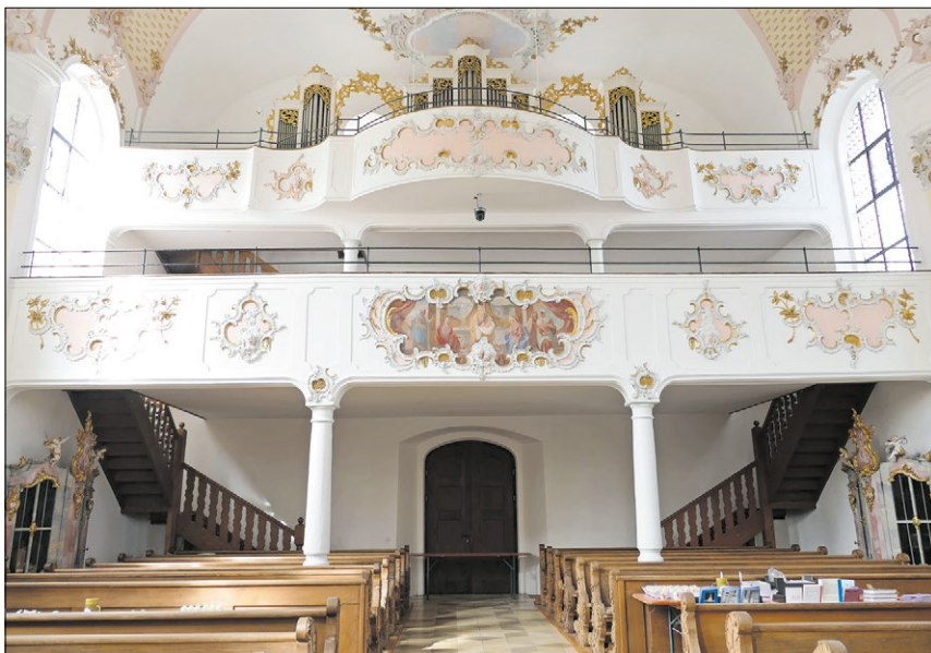
▲ Die Fenster an der Empore waren 1860 im Zuge der neo-romanischen Ausgestaltung zugemauert worden. Jetzt lassen sie wieder viel Licht in die Kirche. Auch das hintere Portal wurde nun wieder geöffnet. Es war in den 1950ern zugemauert worden, da damals die Straße direkt an der Kirche vorbeiführte. Fotos: Kröling
