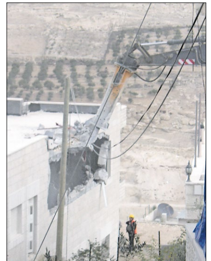
▲ Mit schwerem Gerät zerstören israelische Behörden ein Palästinenser-Haus, das ohne Genehmigung gebaut wurde.
