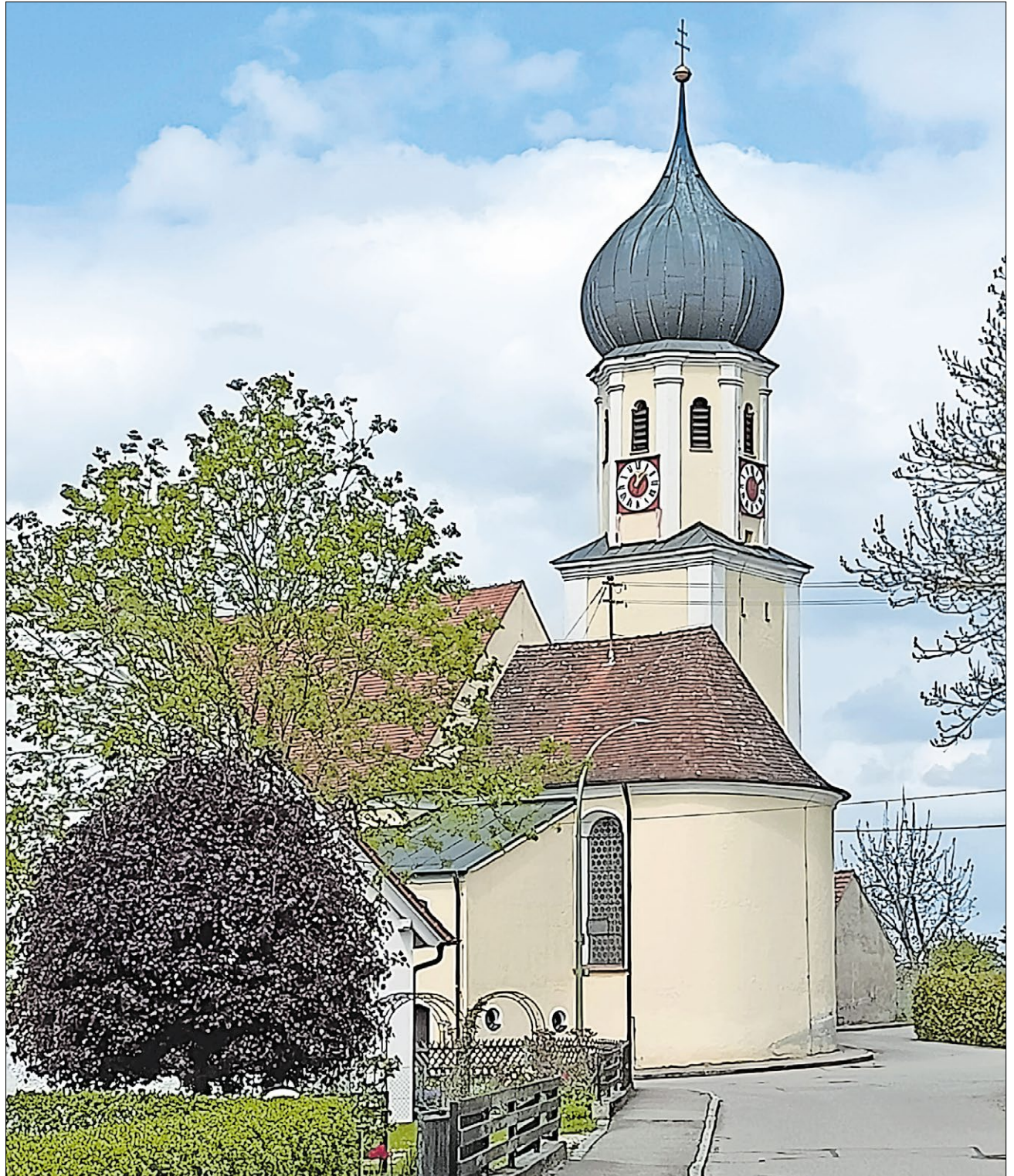
▲ Der Saalbau der Kirche St. Laurentius in Oberbaar stammt aus dem Jahr 1715. Im nördlichen Winkel erhebt sich der quadratische Turm mit Oktagon und Zwiebelhaube. Die Kirche gehört heute zur Pfarrei Thierhaupten. Foto: Beck
