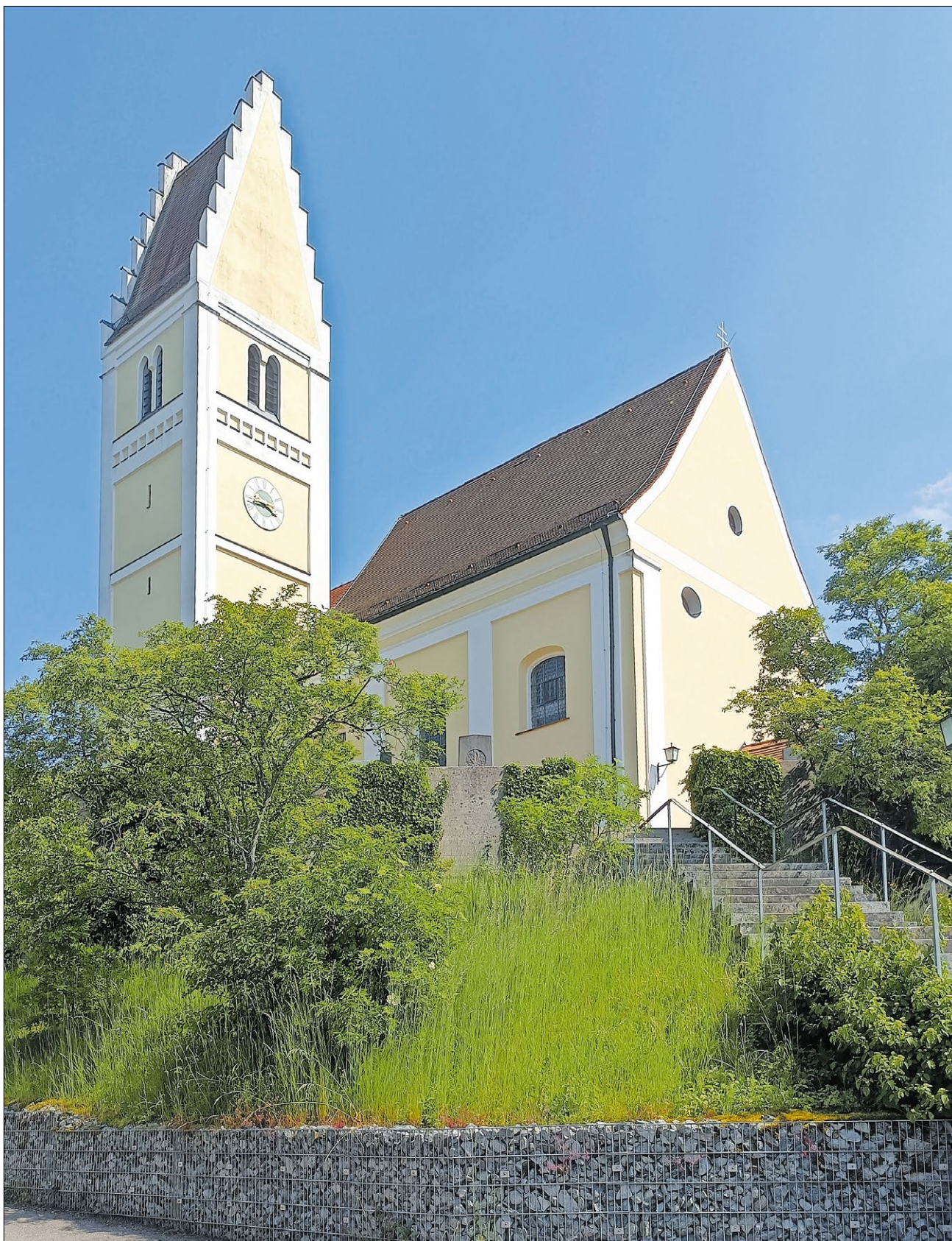
▲ Die Pfarrkirche St. Katharina in Tödenried wird urkundlich erstmals im Jahr 1193 genannt. 1722 wurde der Vorgängerbau der heutigen Kirche abgetragen und ein Neubau errichtet, der 1733 geweiht wurde. Nach dem Neubau kam 1725 am rechten Seitenaltar ein Maria-Hilf-Bild – eine Kopie des Maria-Hilf-Gnadenbilds von Lucas Cranach dem Älteren – in die Kirche, die damit zum Wallfahrtsziel wurde. St. Katharina gehört heute zur Pfarreiengemeinschaft Adelzhausen. Foto: Beck
