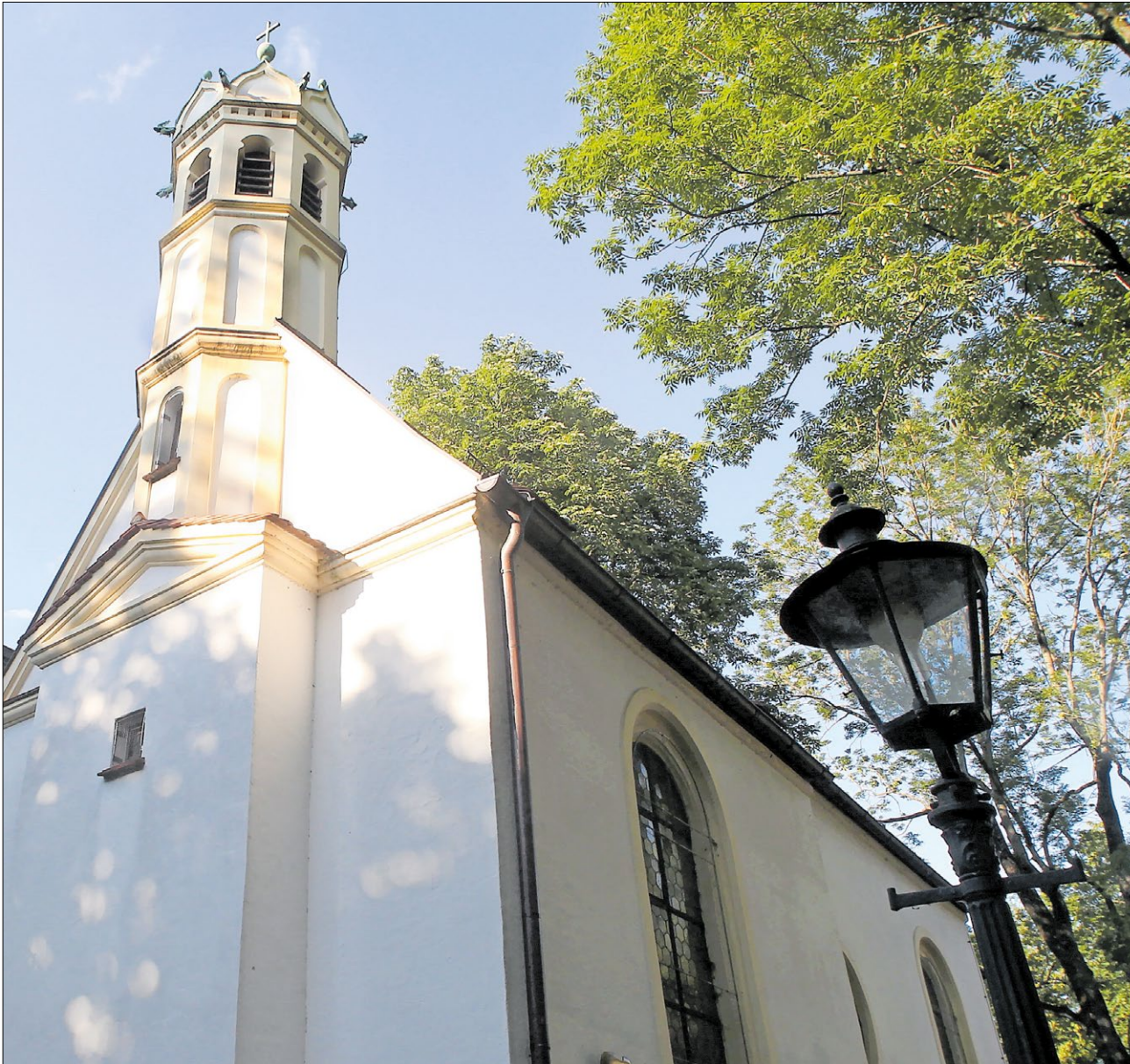
▲ St. Gallus ist die wahrscheinlich älteste heute noch erhaltene Augsburger Kirche. Der Bau ist klein, einschiffig und geht in seinem Kern auf das 11. Jahrhundert zurück. In dem Gotteshaus ist heute die Russisch-Orthodoxe Gemeinde Augsburgs zuhause. Hinter dem Galluskirchle soll Martin Luther seinerzeit in der Nacht vom 20. auf den 21. Oktober 1518 durch ein Türchen in der Stadtmauer geflüchtet sein, daher heißt die Stelle noch heute „Dahinab“.
