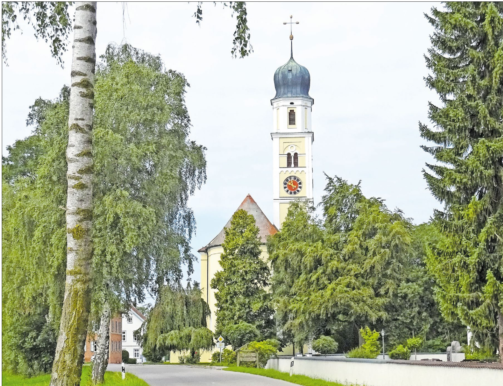
▲ Dem heiligen Johannes dem Täufer ist die Kirche im Langeringer Ortsteil Gennach geweiht. Das 2012 umfassend renovierte Gotteshaus wurde 1610 unter der Leitung von Kapittelbauer Jakob Aschberger erbaut. Es gehört zu den wenigen kaum veränderten ländlichen Sakralbauten der Spätrenaissance in Südbayern. Foto: Krünes
