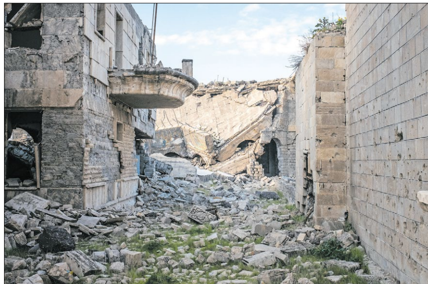
▲ Die chaldäisch-katholische al-Tahira-Kathedrale im irakischen Mossul wurde vom „Islamischen Staat“ verwüstet und bei den Kämpfen gegen die Terrormiliz zerstört.
