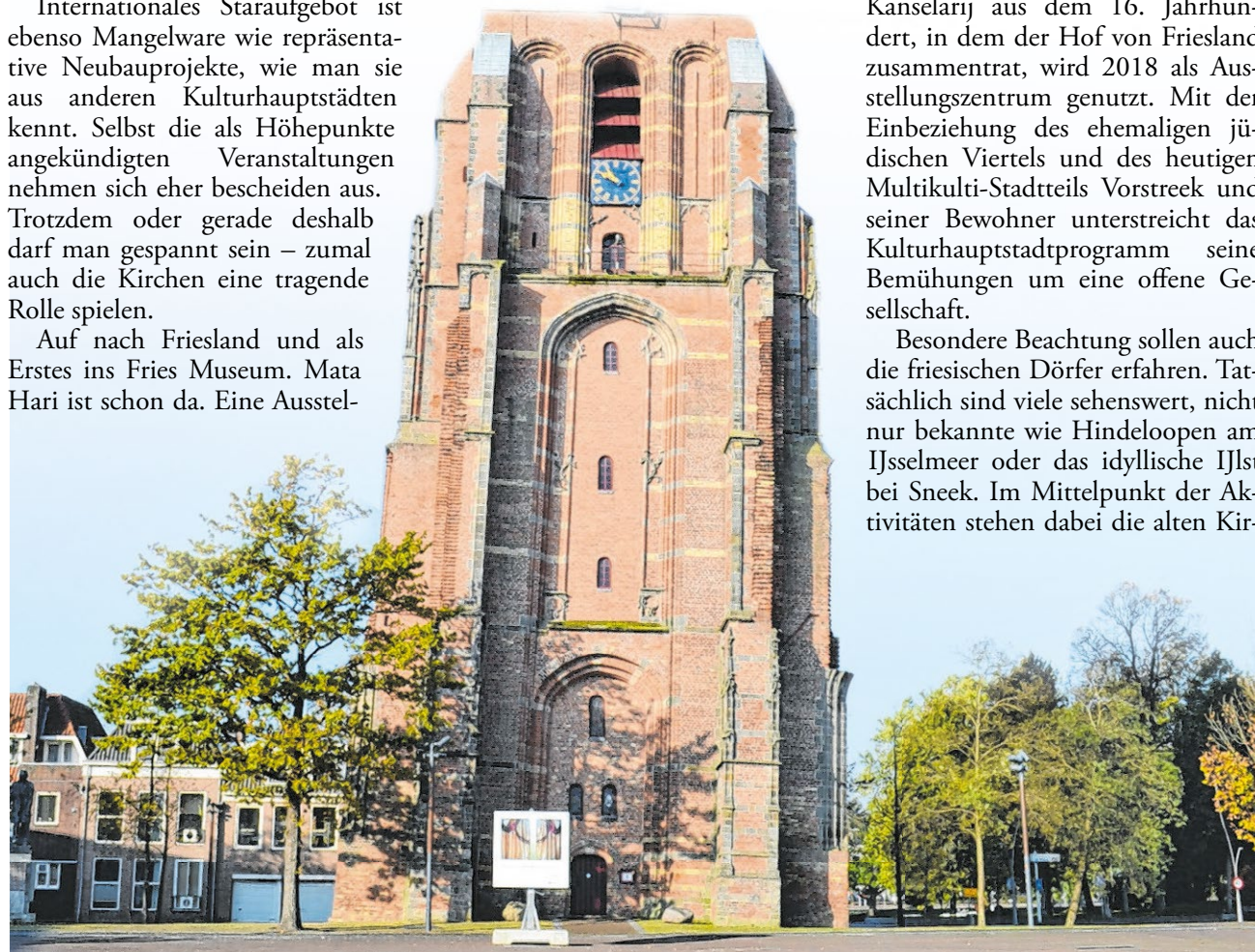
▲ Der Oldehove, der schiefe Turm von Leeuwarden, gehörte ursprünglich zu einer Kirche. Seit diese jedoch im 16. Jahrhundert abgerissen wurde, steht er alleine. Der Turm prägt das Stadtbild und ist zu einem Symbol geworden. Fotos: Traub
