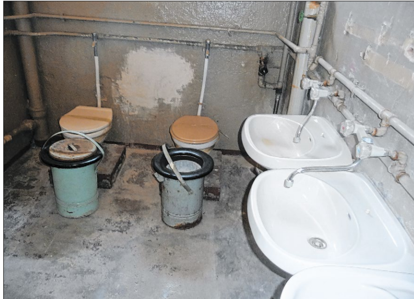
▲ Erst ab 1974 gab es in Hoheneck Toiletten mit Wasserspülung. Fotos: Vallendar
