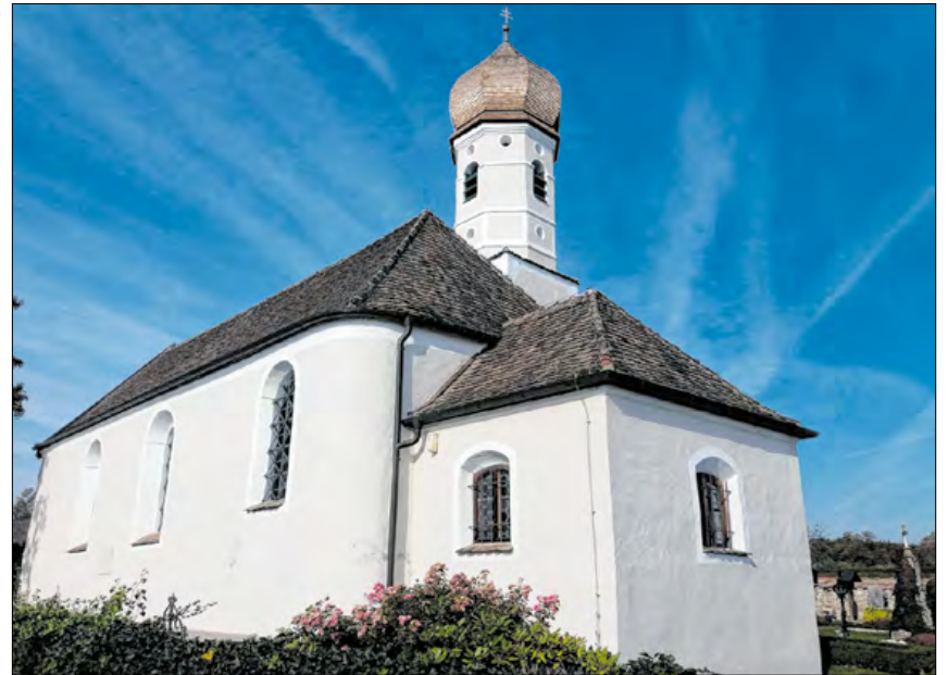
▲ Die Zwiebel des Kirchturms von St. Nikolaus Oberzeismaring wurde mit kanadischen Rot-Zeder-Schindeln eingedeckt. Sie gelten als besonders fäulnisresistent und wetterfest. Fotos: Reitzig
