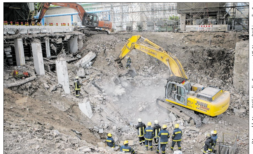
▲ Fehler beim Bau der U-Bahn waren wohl die Ursache dafür, dass vor zehn Jahren das Kölner Stadtarchiv einstürzte. Zwei Menschen starben.
