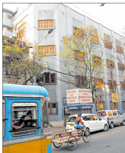
▲ Das Mutterhaus liegt direkt neben einer vielbefahrenen Straße.
