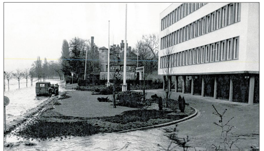
▲ Ob Schnee, Sturm, Regen oder Überschwemmung – hier ein Foto von 1955: Viele Jahre leistete die ehemalige pädagogische Akademie in Bonn treue Dienste als „Bundeshaus“. Die deutsche Wiedervereinigung, hier oft genug beschworen, machte der Verwendung schließlich ein Ende. Foto: imago/ZUMA/Keystone
