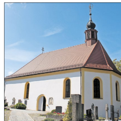
▲ Die Friedhofskirche St. Johannis mit ihrem neuen Dach. Foto: Stiegler
